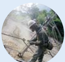
ロックボルト/SD工法
